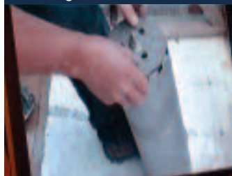
2. L'appareil est vissé à un tampon fixé sur la dalle.
